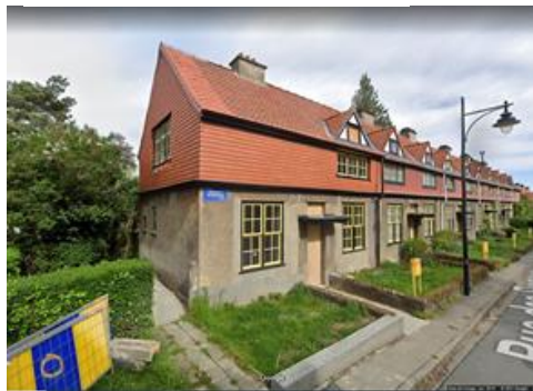
Renoncules 6 : bardage en Eternit déjà remplacé – © Streetview, avril 2019.
