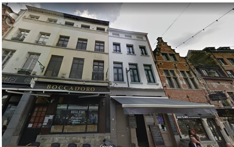
Vue des façades des n°7 à 15 de la rue de Rollebeek. L'Ensemble classé 7-9 est à droite. ©Google Street View 2019.
