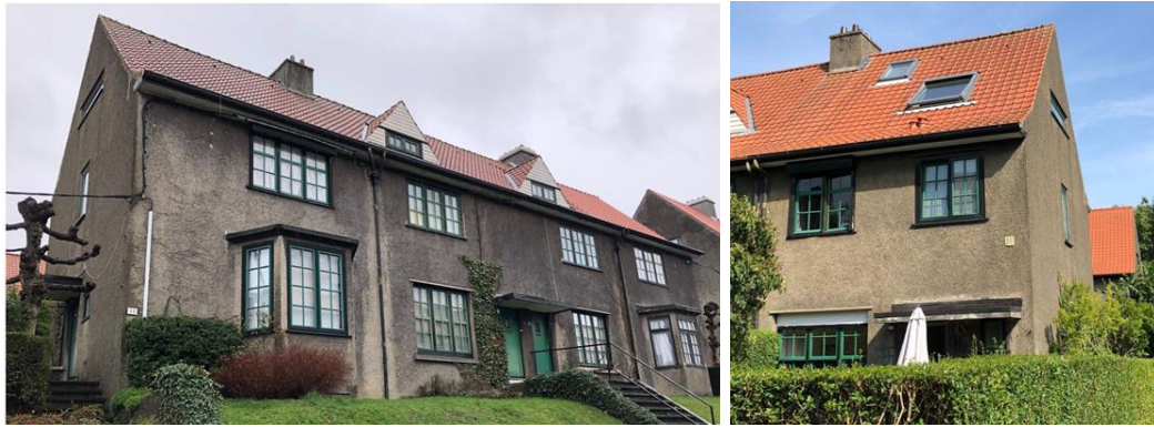
Rue du Coucou, 15 – façades avant et arrière (extr. du dossier de demande)
