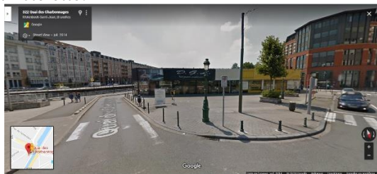
Vue de l'entrepôt avant l'incendie, depuis la place Saintelette, © Google maps 2014
