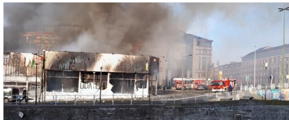
Incendie en février 2018
