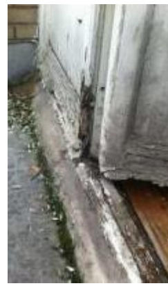
Détail de la porte fenêtre en façade à rue
