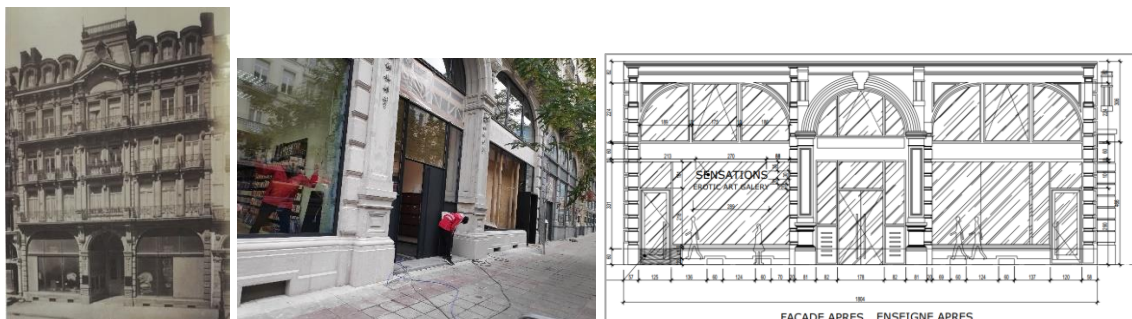
État original de la façade et chantier de restauration des devantures effectué en 2020 (photos Urban.brussels) ; projet d'enseigne (document joint à la demande de permis)
