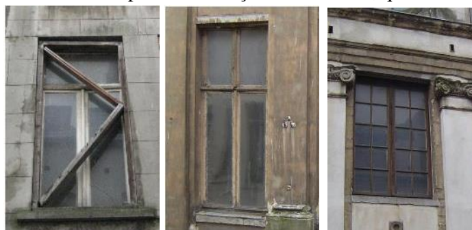
De gauche à droite, châssis type en façades avant des maisons n°s 23, 21 et 19 (photos jointes au dossier)
