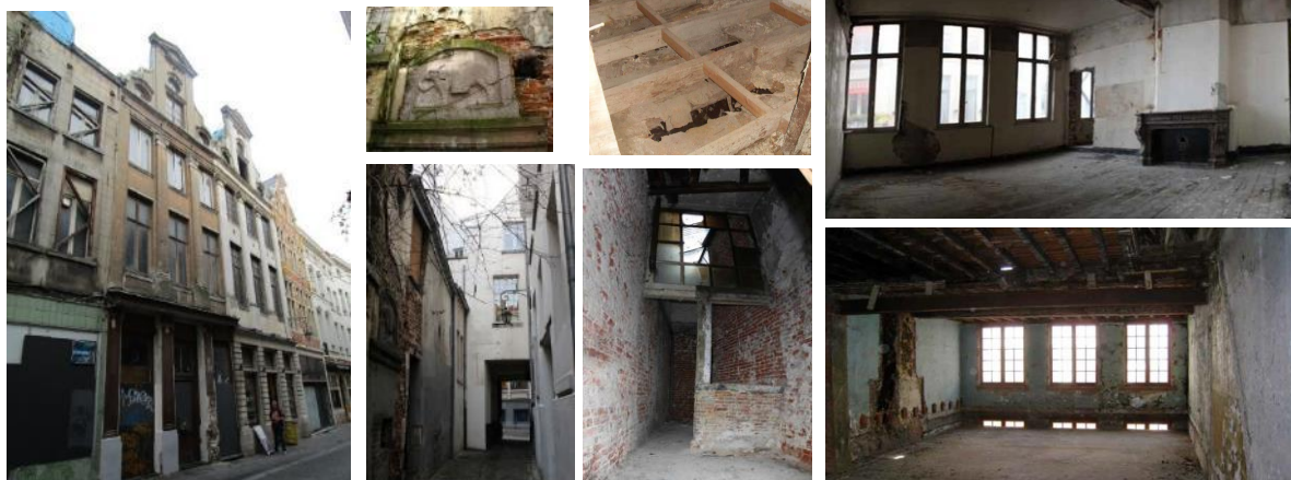
Rue des Chapeliers 23, 21, 19 et Petite rue de la Violette, état des façades en 2014 ; intérieur du n° 23 (à gauche), n° 21 (en haut à droite) et n° 19 (en bas à droite) – état en 2012 (photos jointes à la demande)
