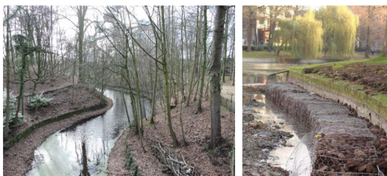
A gauche : état actuel. A droite : mise en œuvre de gabions à l'étang du parc Léopold à Bruxelles (extraits du dossier)
