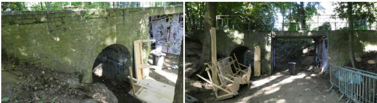
Petit pont en maçonnerie (extraits du dossier)
