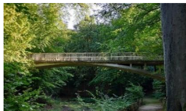
Passerelle en arc – 1935
