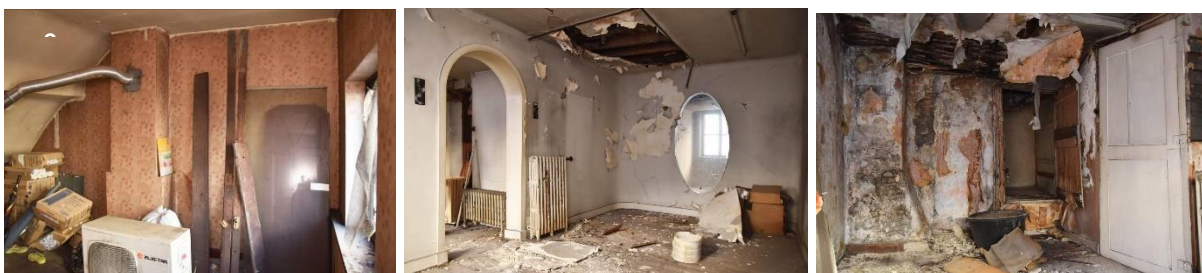
État de conservation des pièces aux étages (État de référence © Urban.brussels)
