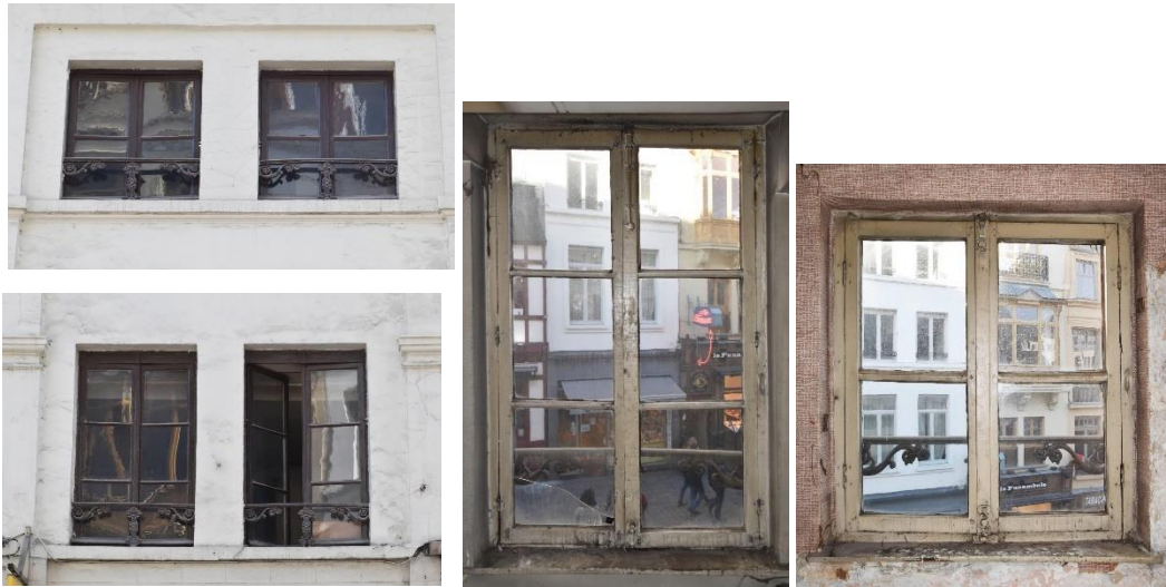
Menuiseries présentes aux étages du n° 12 (État de référence © Urban.brussels)
