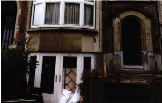
Porte de garage à quatre panneaux placée dans les années '90. Image extraite du dossier de demande
