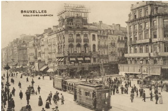
Vue sur l'angle Boulevard Anspach / Rue Jules Van Praet. Avant 1920. Coll. Belfius.
