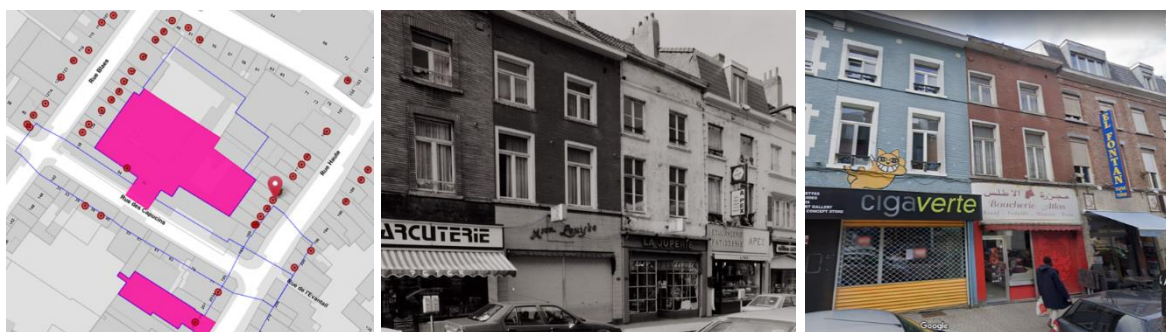
Implantation de l'immeuble, vue en 1980 et vue actuelle (©Brugis, ©Urban.brussels et ©Google maps)
