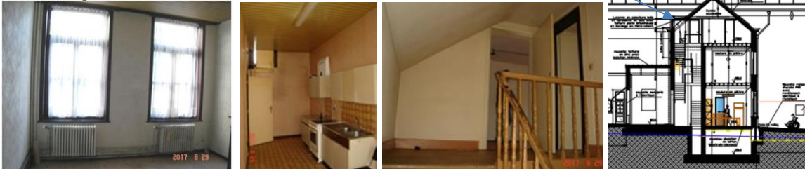
Vues du jardin et des annexes, ainsi que de l'état général de la maison : hall, cage d'escalier, ancien salon, ancienne cuisine, palier des combles. Élévation projetée de la nouvelle lucarne (extr. du dossier de demande)
