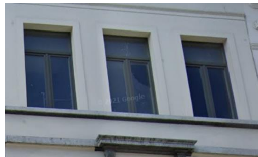
Huidige PVC-ramen © StreetView
