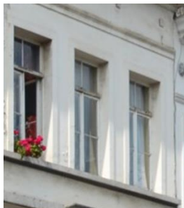
Oorspr. ramen voorgevel in 2016 –© Urban.brussels
