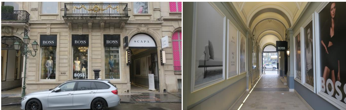
Vues actuelles du rez-de-chaussée et du passage cocher vu depuis la cour, avec les trois vitrines obturées à droite (©CRMS, 2022)
