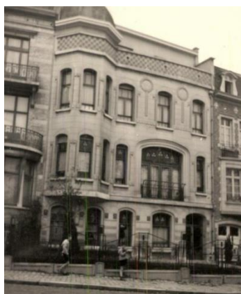
Photo de 1961 avant les travaux en toiture – Photo extraite du dossier de demande
