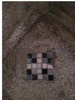
Détail de l'escalier en granito
