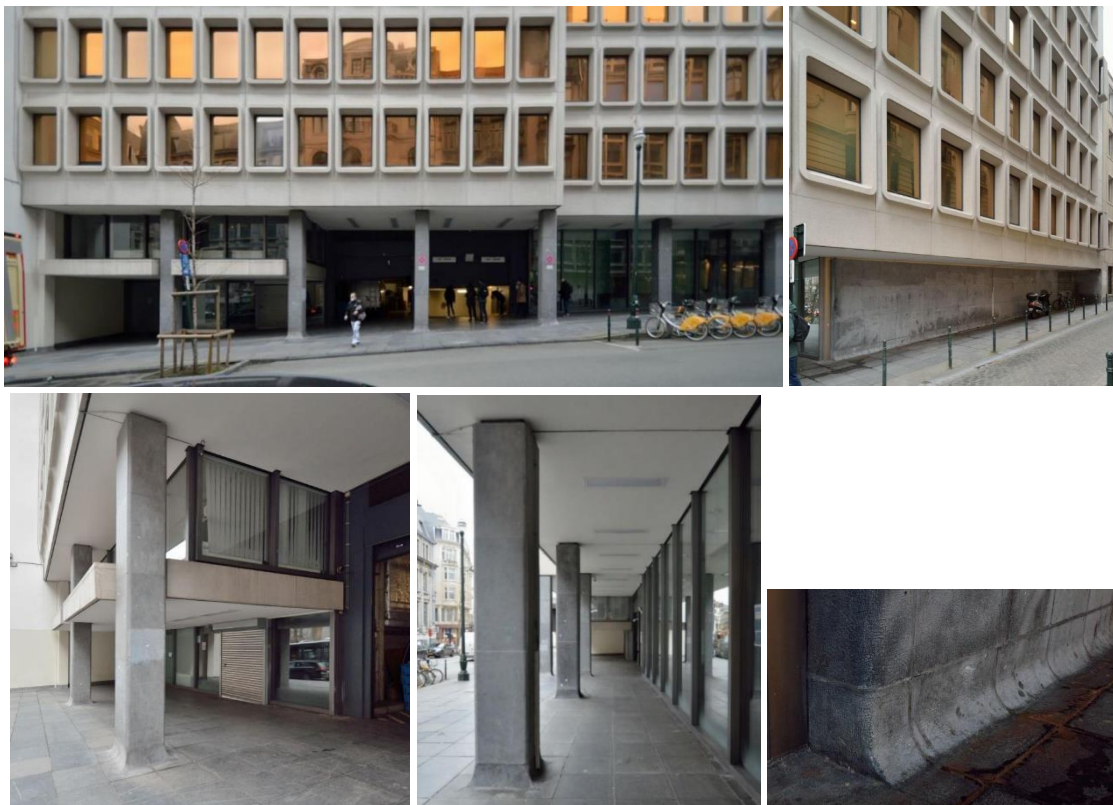
Façades du rez-de-chaussée extraites de la note patrimoniale DPC (photos © Urban.brussels)
