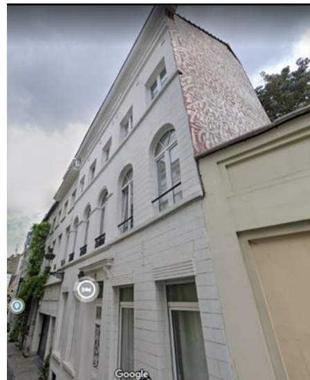
n°18-20, rue Coppens (Google Maps ; 2020)
