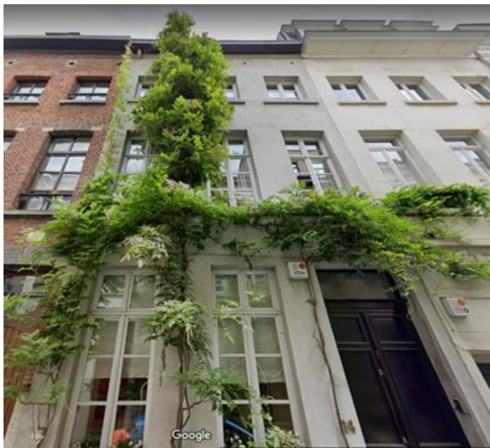
n°14, rue Coppens (Google Maps ; 2020)
