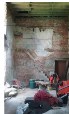
Vue vers l'ancien escalier. Photo Urban.brussels©2021
