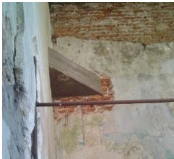
Console en béton Photos Urban.brussels© 2021
