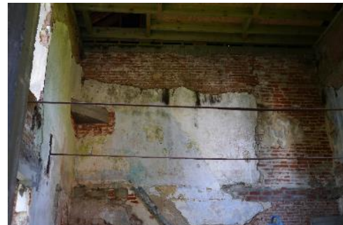
Tirants en fer et plancher
