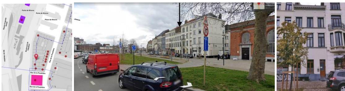
Inplanting, plaats van het pand in het gevelfront en bestaande toestand van de voorgevel (©Brugis en © Streetview)
