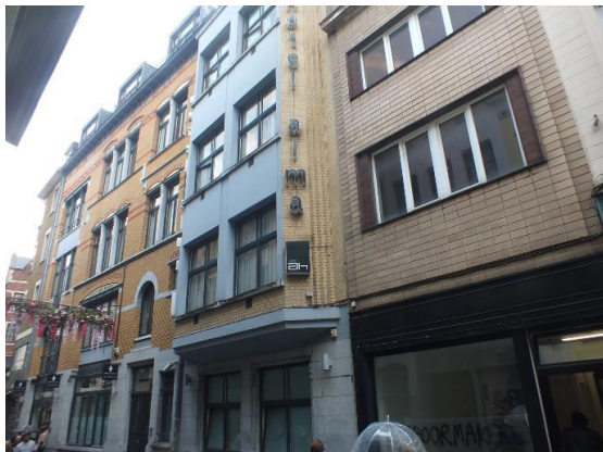
Vue du bien dans l'alignement de la rue. Photo CRMS. Septembre 2022
