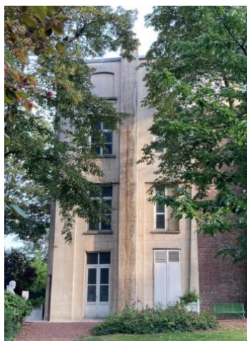
Façade Nord-Ouest existante – extr. du dossier de demande
