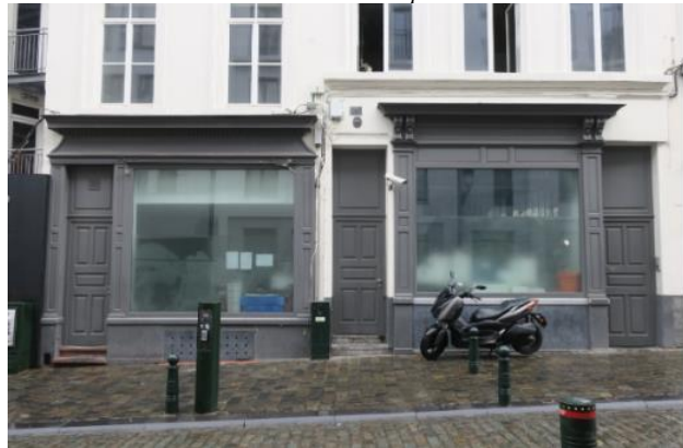
Photo de la façade en 2022. Photos CRMS
