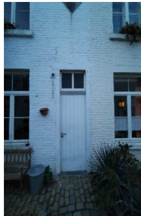
Photo d'une porte des maisons d'origines. Photo CRMS
