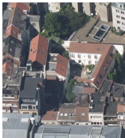
Vue aérienne de l'impasse. ©Bing Maps
