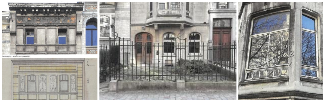
A gauche, vue de l'état actuel du sgraffite et de son projet en 1906. Au centre, la zone de recul aujourd'hui. A droite, vue du bow-window et de son châssis (extraits du dossier)
