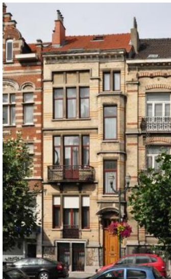
Façade à rue : état existant (photo jointe à la demande)
