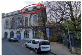
Localisation des grilles de ventilation à remplacer par des châssis. Image ©Google Street View modifiée par la CRMS
