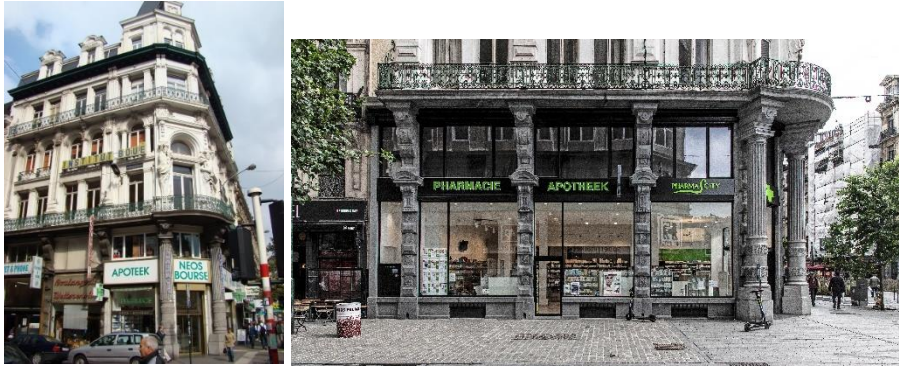
Anspachlaan 61, toestand voor en na de restauratie (© urban.brussels)
