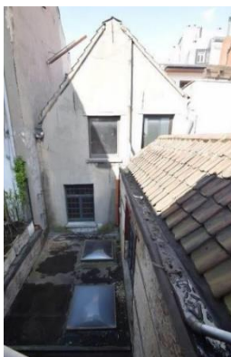
Articulation de l'aile de liaison avec la façade sur cour de la maison avant
