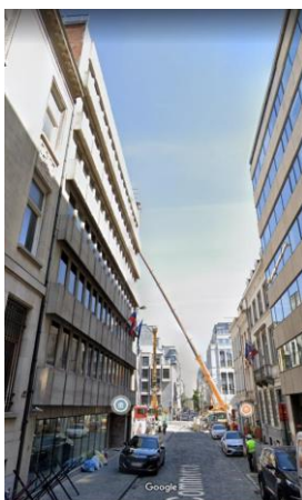
Vue de l'immeuble à gauche et de l'atelier Hasyir à droite
