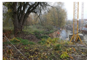
Chantier en cours © urban.brussels
