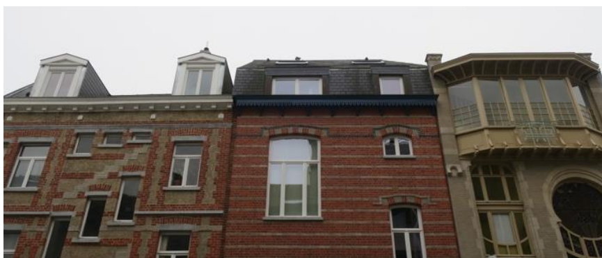
Photo des toitures de l'enfilade Rue du Lac. Photo CRMS - 2023
