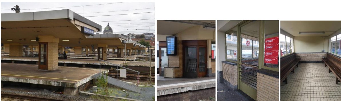
Overkappingen van de sporen en oorspronkelijke elementen © urban.brussels
