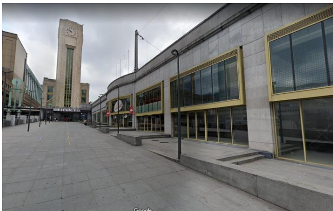
Zuidgevel en colonnade © Google Earth
