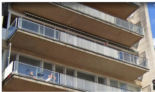
Détails des balcons © StreetView
