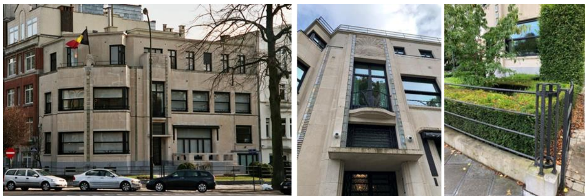
Vue générale de l'ancien Hôtel Pieper, de sa travée d'entrée et du garde-corps bordant le jardinet à rue (©Urban.brussels)
