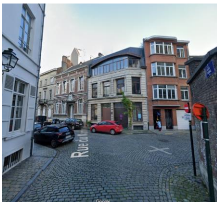
Vue de l'immeuble depuis la Rue des Lilas. ©Google Street View. 2020.
