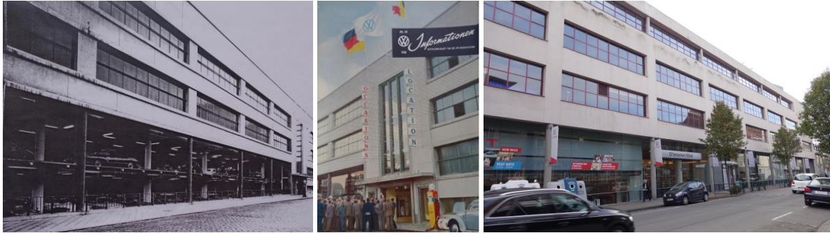
A g. : le « Badoux », bâtiment rue Américaine en chantier, vers 1956, arch. F. Badoux (Archives D'Ieteren Gallery) - Au milieu : le bâtiment en 1958 (extr. du VW INFORMATIONS 40, 1958) - A dr. : vue en 2015 (extr. de l'Etude historique et pathologique )
