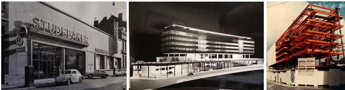
A g. : façade du bâtiment rue du Mail en 1952 (archives D'Ieteren Gallery) – Au milieu : le « Stapels » maquette du futur complexe des Anciens Établissements D'Ieteren Frères , 1960-61 (photo publiée dans le Rapport annuel D'Ieteren , 1961) A dr : Vue du chantier (phase II), 1965 (Archives D'Ieteren Gallery)
