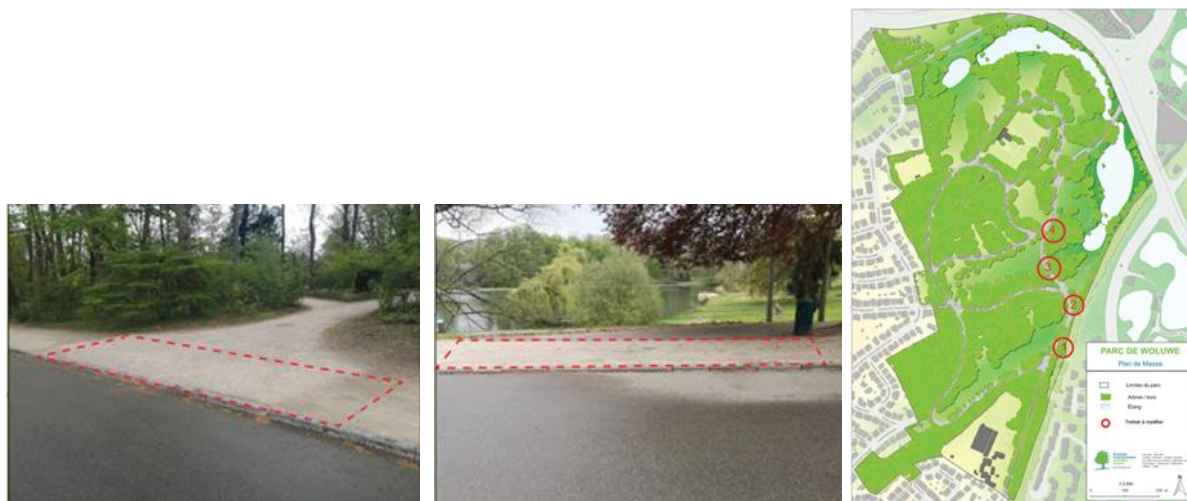
Zones de dolomie à remplacer par de la dolomie stabilisée (extr. du dossier de demande)
