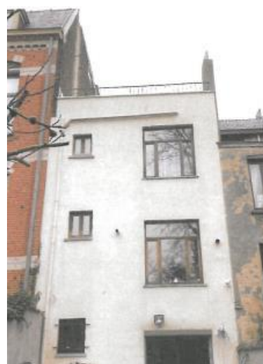
Photo de la façade arrière (Photo tirée du dossier)
