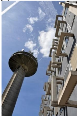
Détail des façades des bâtiments et vue sur la Tour des télécommunications ©Urban.brussels
