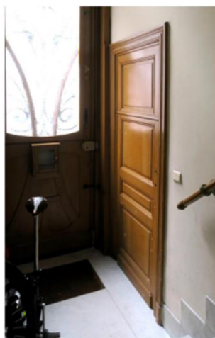
Rue Vanderschrick, n°15. Porte de la cave avec partie supérieure fixe. © ARCHistory.
