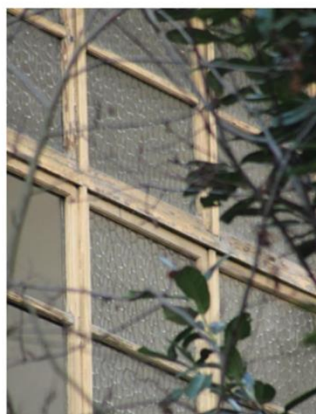
Châssis bois avec verre cathédrale clair (1935), 17 rue Vanderschick.
