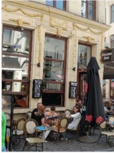
État de la façade de la rue des Chapeliers en mai 2023 (photo CRMS)
