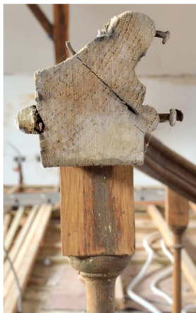
Figure 8 : profil de la main-courante (W. Kenis © urban.brussels ; 2020)
