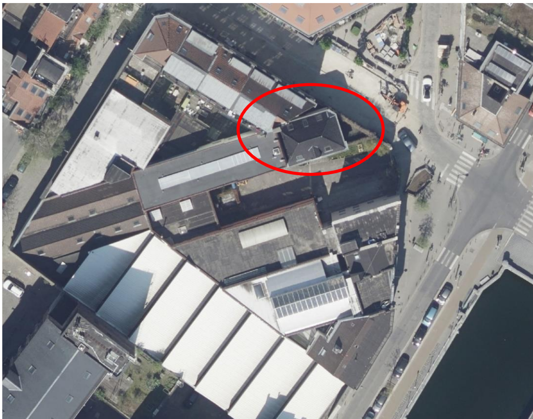
Figure 1 : vue aérienne du bien (Orthophoto de 2019 https://mybrugis.irisnet.be/brugis/#/ )
