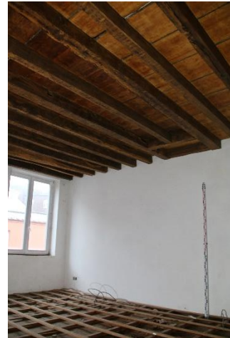
Figure 11 : lames de plancher en bois (S. Modrie © urban.brussels ; 2020)
