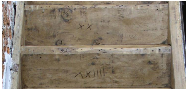
Figure 9 : arrière des marches d'escalier (S. Modrie © urban.brussels ; 2020)
