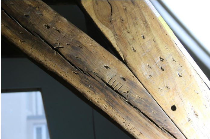
Figure 10 : charpente en bois, détails (S. Modrie © urban.brussels ; 2020)
