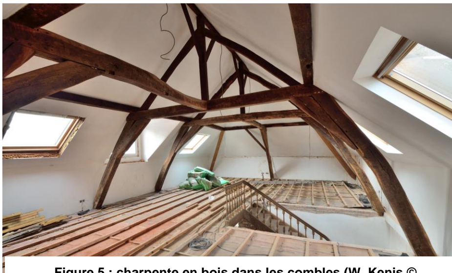
Figure 5 : charpente en bois dans les combles (W. Kenis © urban.brussels ; 2020)
