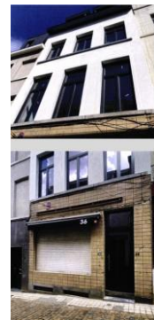
État de fait de la façade à rue (photos jointes à la demande)
