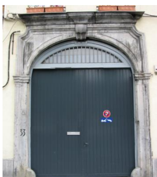
Porte cochère n°33 – état existant
