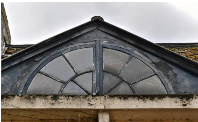
lucarnes en travée d'entrée et en façade à rue (IPA ; 2017)
