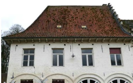
Toiture existante (photo extraite du dossier)
