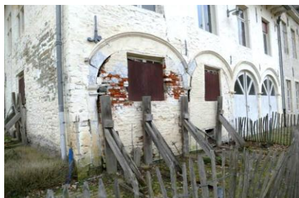
Façade nord du logis de ferme et arches comblées (Photographie extraite du dossier de demande)
