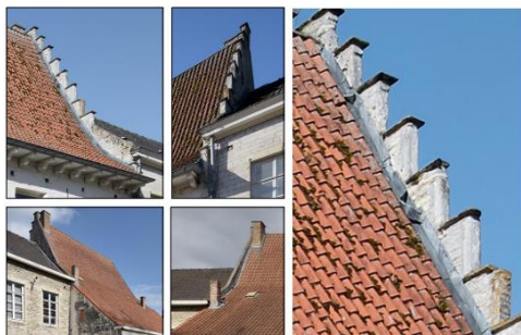
Pignon existant (Photos extraites du dossier)
