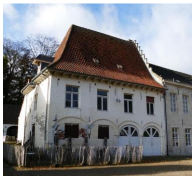
Logis de ferme du Rouge-Cloître avant sa stabilisation (photo extraite du dossier de demande).
