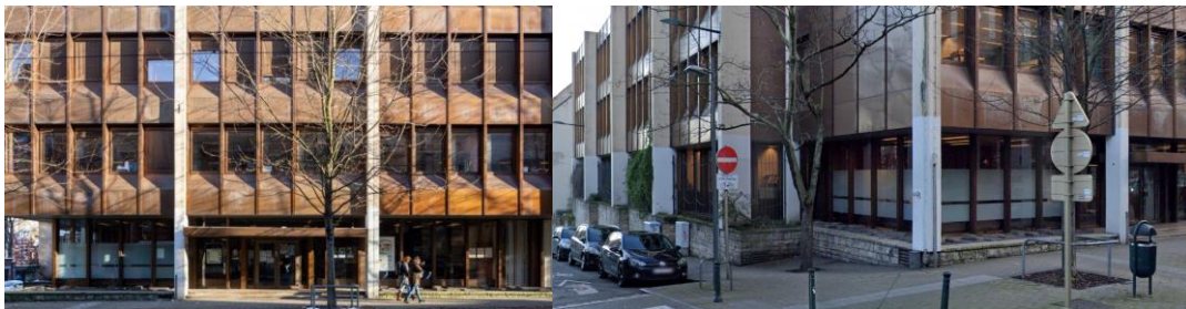
Gevel aan de Haachtsesteenweg en hoekpartij met de Ooststraat (foto's uit het erfgoedverslag van de DCE)
