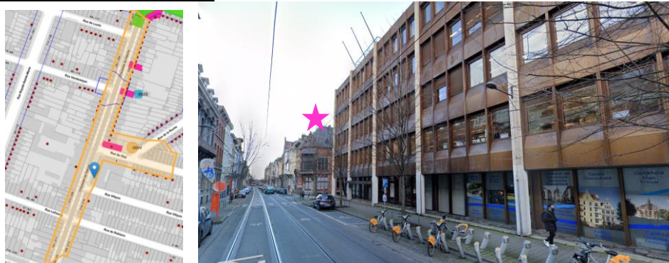
Erfgoedlocatie © Brugis en, bestaande toestand van het gebouw (© Google Streetview)
