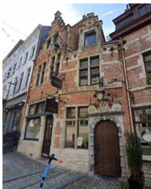
Façade avant Rue de Rollebeek. ©Google Street View
