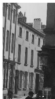
Façade du n° 20-22 en 1910 (© KIK-IRPA)
